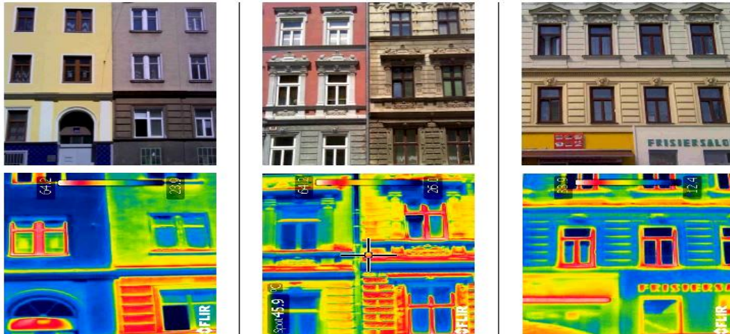
شكل (15): مجموعة أخرى من أمثلة لواجهات المباني المختارة والصور الحرارية التي تم التقاطها باستخدام كاميرا التصوير الحراري بالأشعة تحت الحمراء [20] [21].
