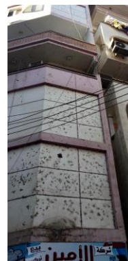
(أ): مبنى سكني رقم (1)
