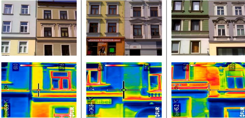
شكل (14): مجموعة أخرى من أمثلة لواجهات المباني المختارة والصور الحرارية التي تم التقاطها باستخدام كاميرا التصوير الحراري بالأشعة تحت الحمراء [20] [21].
