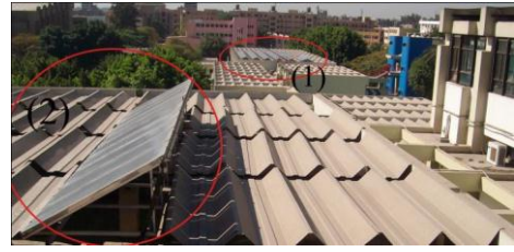
شكل (20) وضع الخلايا فوق السقف عند المسرح والصالة الرياضية وسهولة رويتها من المباني الخلفية مع عدم الوصول إليها، المصدر: زيارة ميدانية للباحثة.
