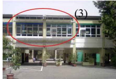
شكل (21) استخدام الخلايا الكهروضوئية في تشكيل الواجهة علي شكل كاسرات كهروضوئية وتميز المدخل - المصدر: زيارة ميدانية للباحثة.
